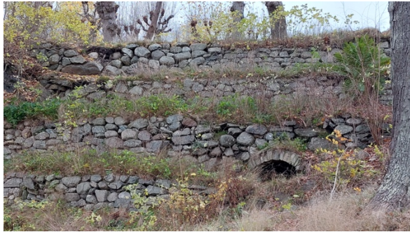
De fire murene før restaurering. Bildet tatt høsten 2021. Begge de nederste murene er i ferd med å rase ut. Den vestre delen av de to øverste er også veldig dårlige.
