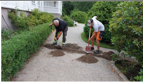
Nytt vannrør måtte legges helt oppe fra huset og ny vannpost settes opp.
