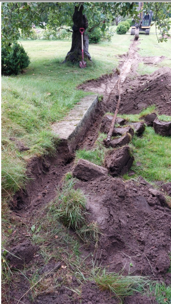
Rustne jernrør ble skiftet ut gjennom hele hagen
