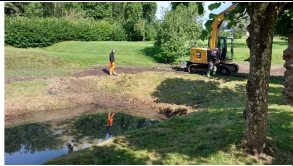
Det meste av gravingen ble gjort med maskin som også renses ut av dammene.
