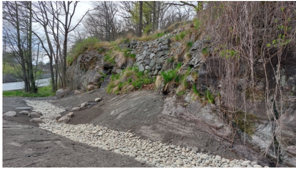
2. mai 2022 – dreneringsgrøft anlagt
