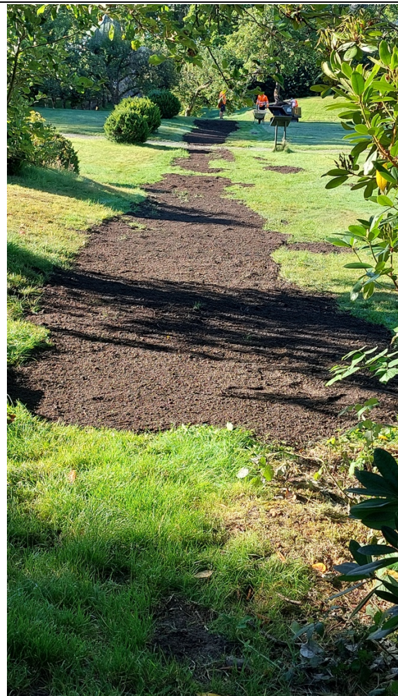
Grøft ble planert og tilsådd
