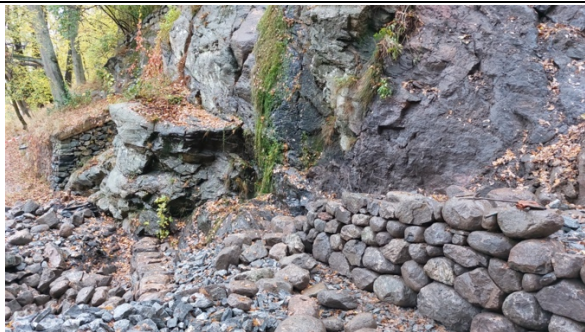
Den nederste muren bygges. Eremitthytta ses bak knausen og den nedre dammen skal gjenoppstå fra steinrøysa nede til venstre.
