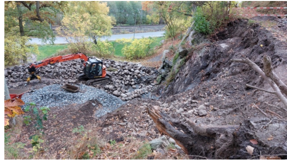
17. oktober: Murene er tatt ned og nytt fundament er på plass.
